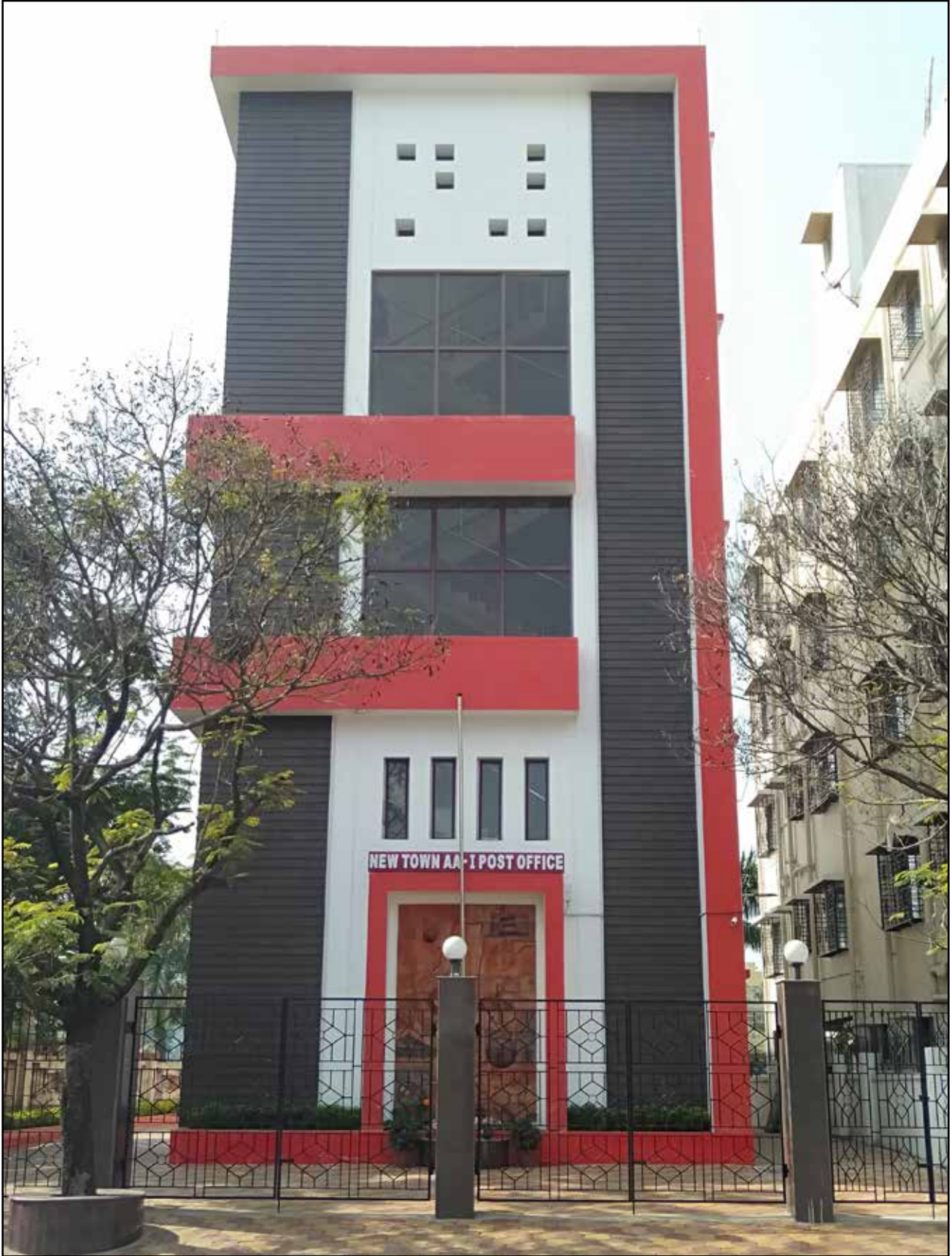
न्यू टाउन, कोलकाता में नवनिर्मित डाकघर भवन
