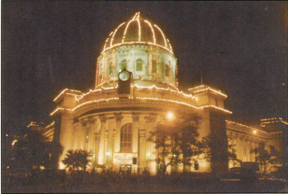
कलकत्ता जीपीओ भवन (1868 में निर्मित), स्वतंत्रता की 50वीं वर्षगांठ के अवसर पर Calcutta GPO building (constructed in 1868) on the occasion of 50th Anniversary of Independence
