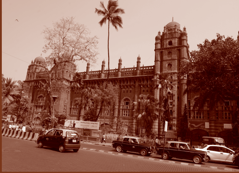
जनरल पोस्ट ऑफिस, मुम्बई GENERAL POST OFFICE, MUMBAI
